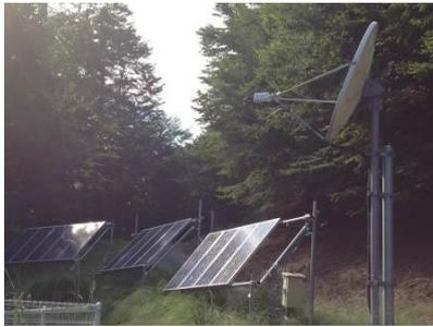
図 2 サイバーフォレストプロジェクトサイトの電源・情報インフラ機材
